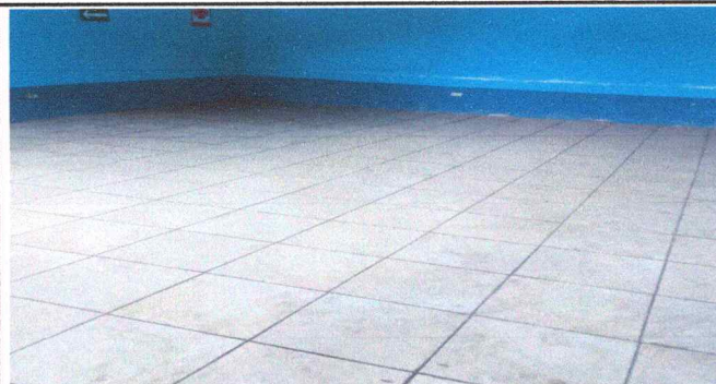
Foto 8: Piso en buen estado
