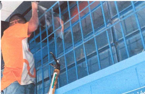
Foto 5: Instalación de vidrios
