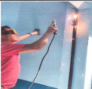
Foto 3: Instalación de puerta
