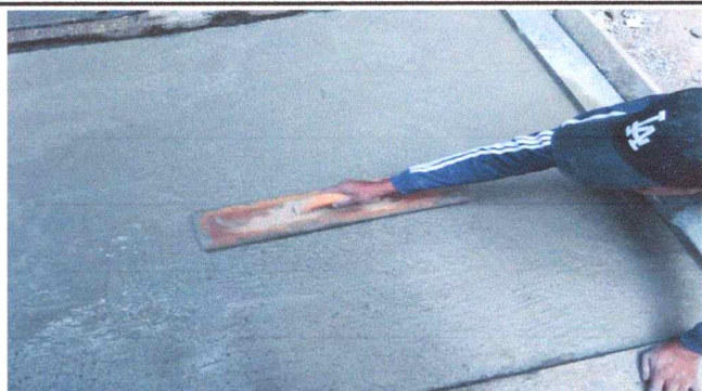
Foto 7: Elaboración de torta de cemento
