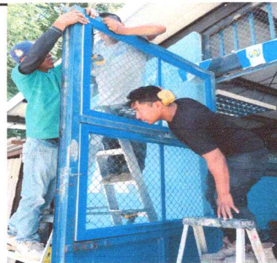
Foto 4: Instalación de ventana
