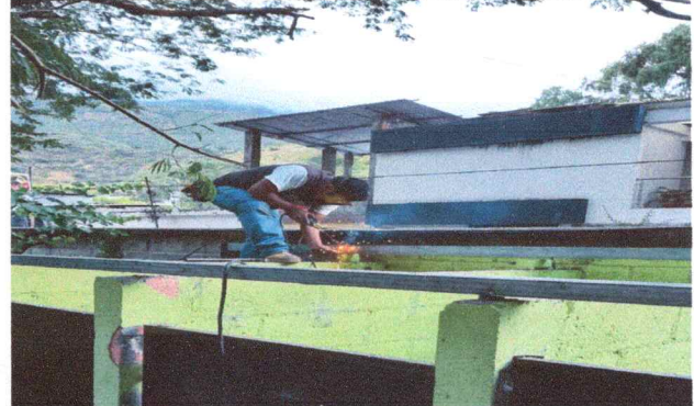
Foto 2: Instalación de soporte de metal
