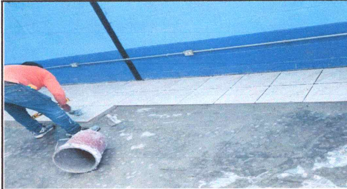
Foto 8: Instalación de piso
