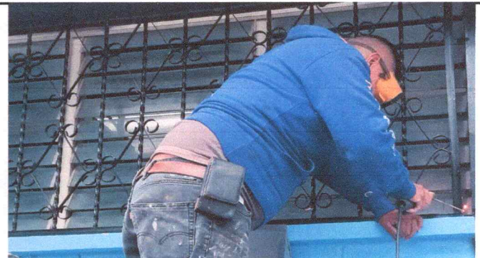
Foto 6: Instalación de balcones
