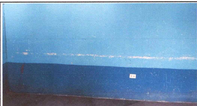
Foto 9: Pintura Deteriorada
