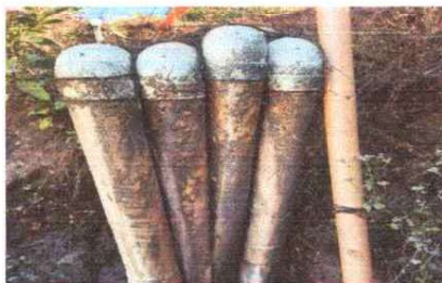
Foto 5: Mantenimiento de tuveria para agua pluvial
