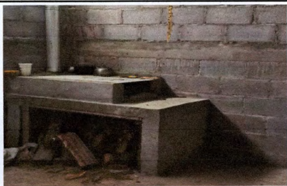
Foto 9: Estufa rural en mal estado
