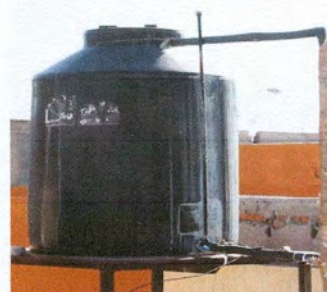
Foto 10: Deposito de agua en mal estado
