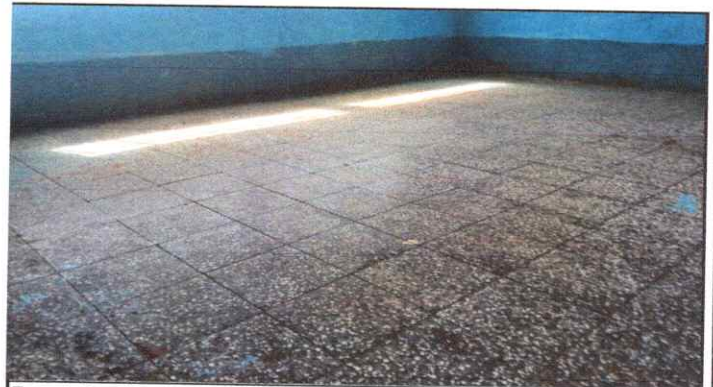
Foto 4: Sustrucción de piso de granito
