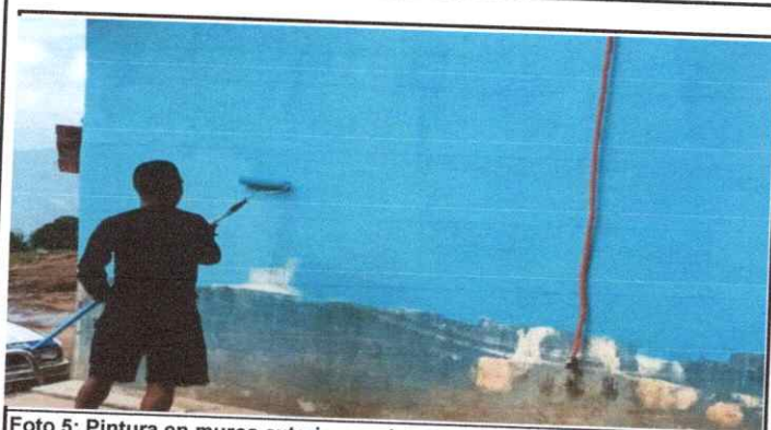
Foto 5: Pintura en muros exteriores e interiores
