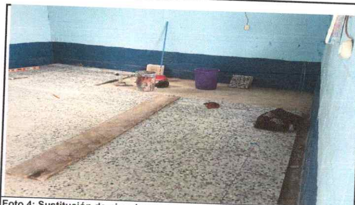
Foto 4: Sustitución de piso de granito
