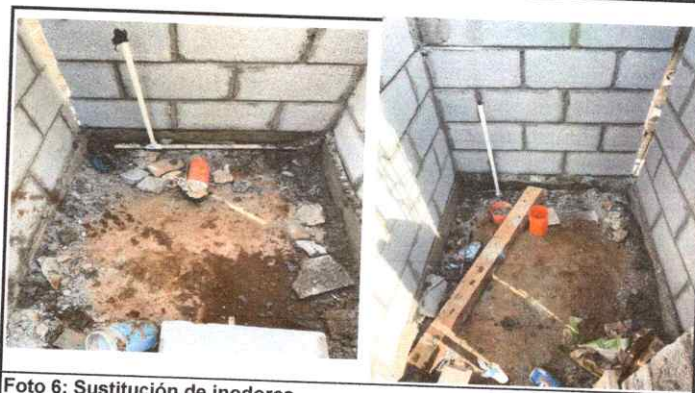
Foto 6: Sustitución de inodoros
