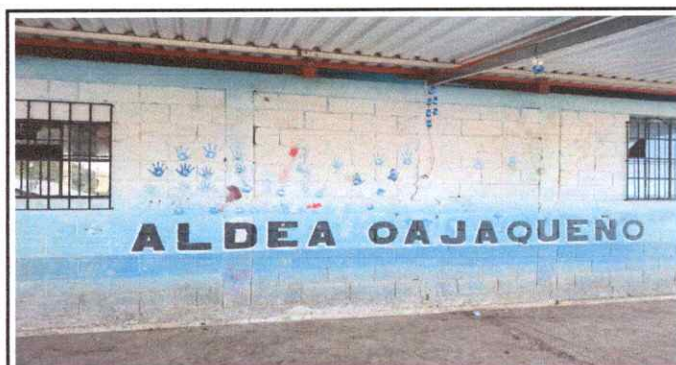
Foto 5: Pintura en muros exteriores e interiores
