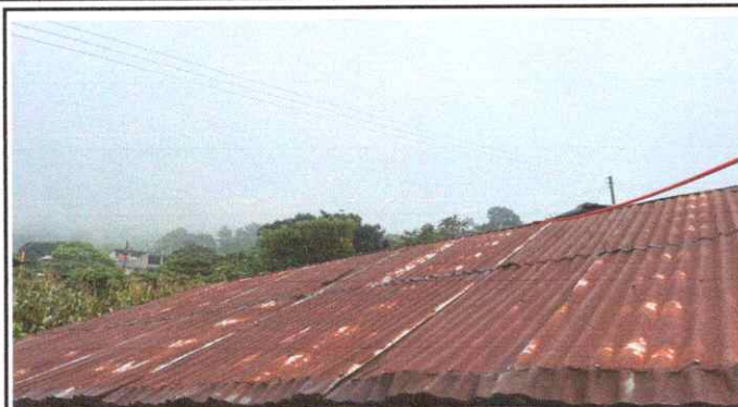
Foto 1: Cubierta de lámina
