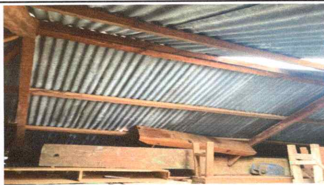
Foto 2: Estructura de techo
