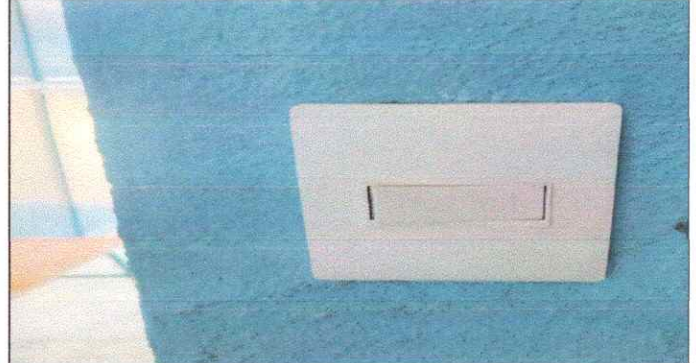
Foto 8: Sustitución de interruptores.
