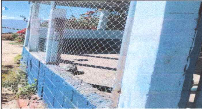
Foto7: Reparación de muro perietral, tubo hg y malla galvanizada.
