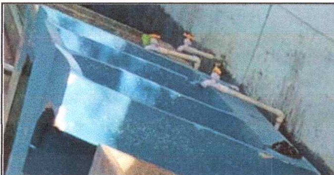
Foto 11: Sustitución de pila de concreto de dos lavaderos.
