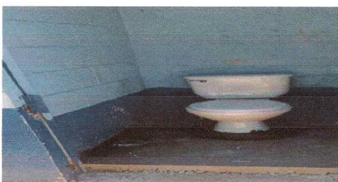
Foto 6: Sustitución de inodoros.
