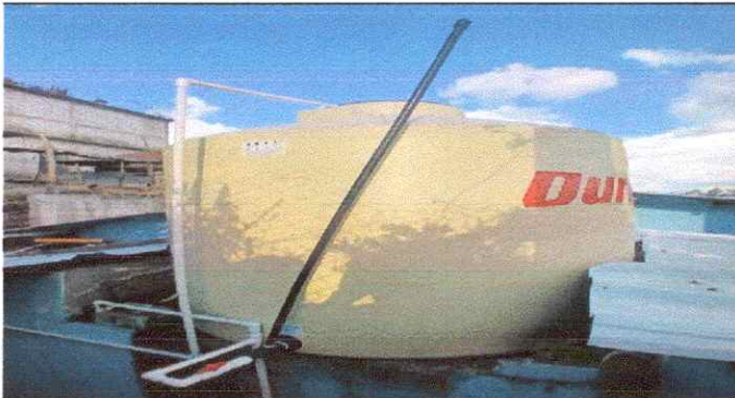
Foto 9: Sustitución de depósito de agua 2500 litros.
