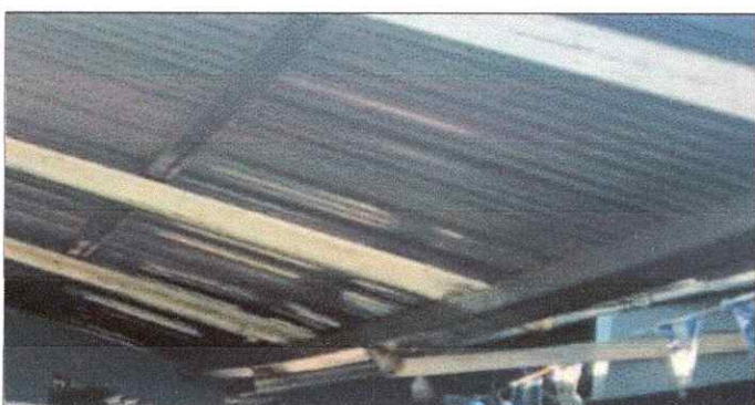
Foto 5: Sustitución de canales de metal.
