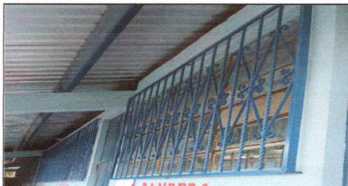
Foto 3: Sustituciones de balcones de metal.
