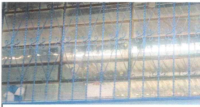
Foto 4: Sustitución de vidrios.
