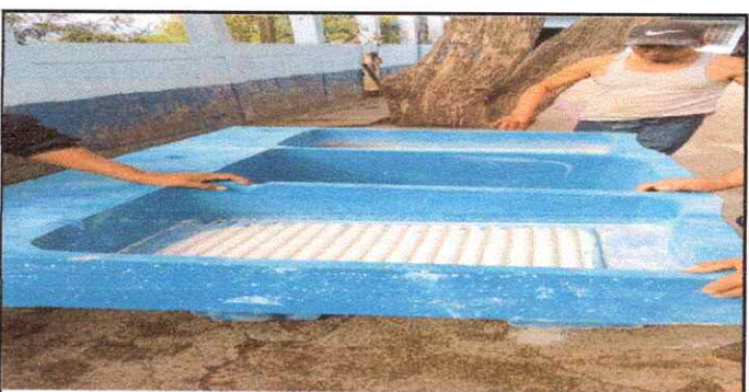
Foto 11: Colocación de pila de concreto de dos lavaderos
