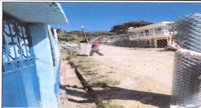
Foto7: Colocación de malla.
