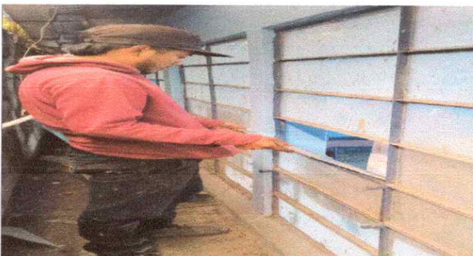
Foto 4: Colocación de vidrios.
