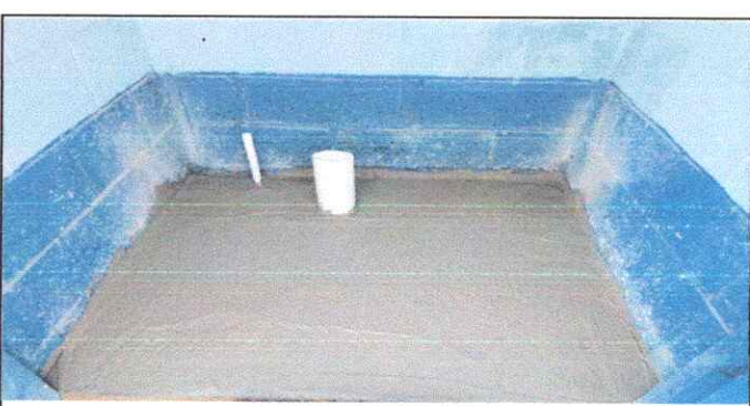
Foto 6: sustracción de inodoros.
