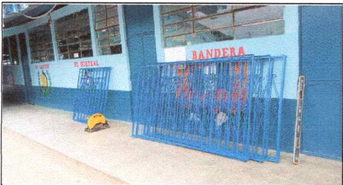
Foto 3: Balcones para ser colocados.
