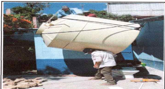
Foto 9: Colocación del depósito de agua.
