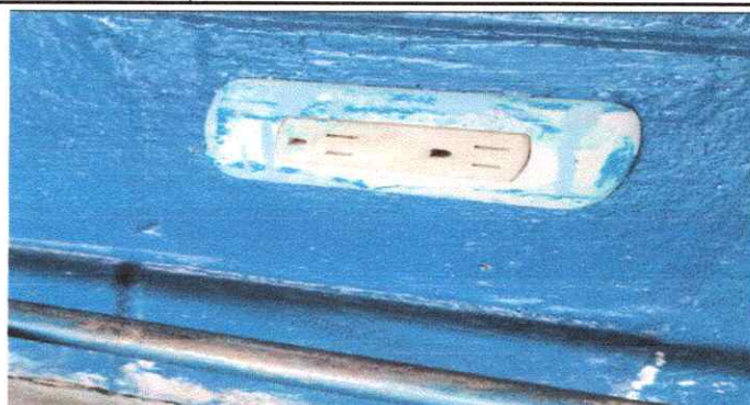
Foto 8: Cambio de tomacorriente.
