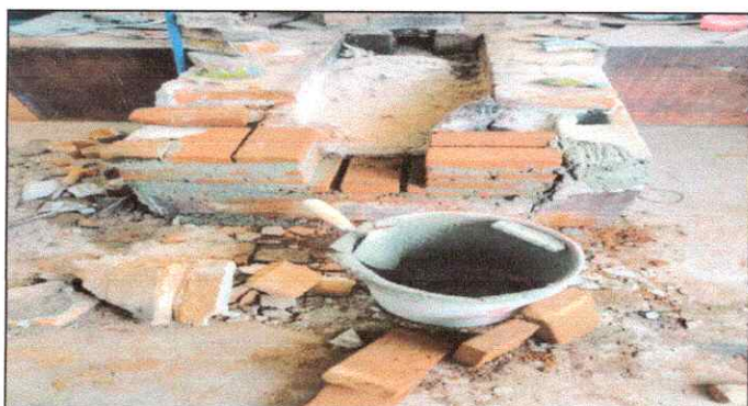
Foto 10: Mantenimiento de estufa rural.
