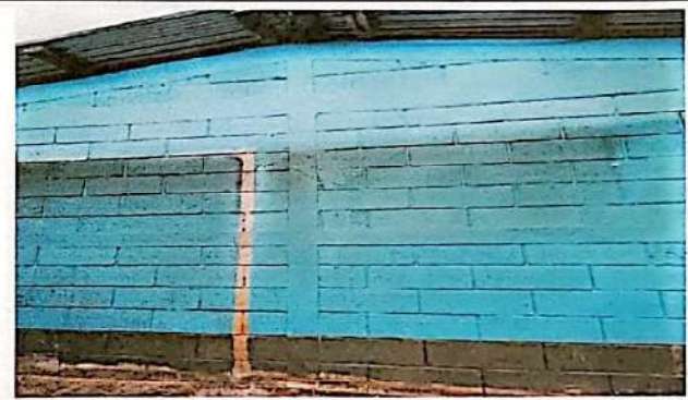
Foto 10: Pintura en muros exteriores e interiores en mal estado
