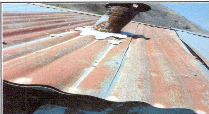
Foto1: Techo de cocina y bodega.
