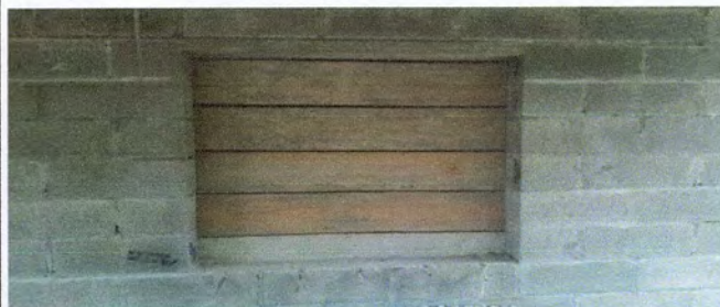
Foto 2: Mantenimiento de ventanas
