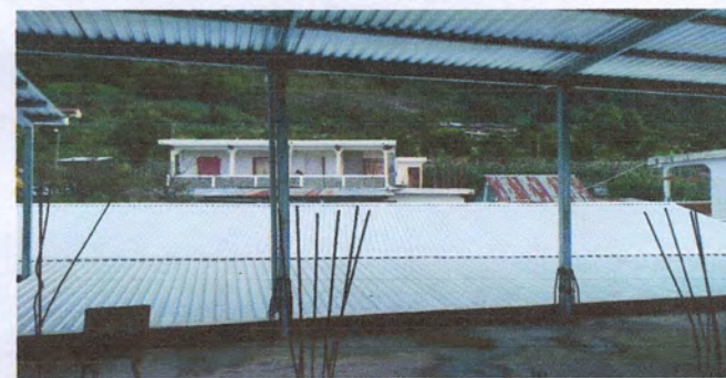
Foto 5: peligro; parte norte del área donde se pondrá maya perimetral
