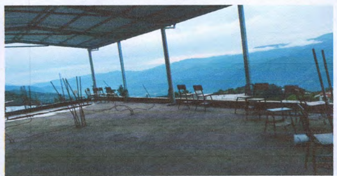
Foto 4: área en la que se pondrá piso mejorado
