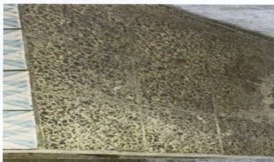
Foto 9: Mueble de cocina en mal estado.
