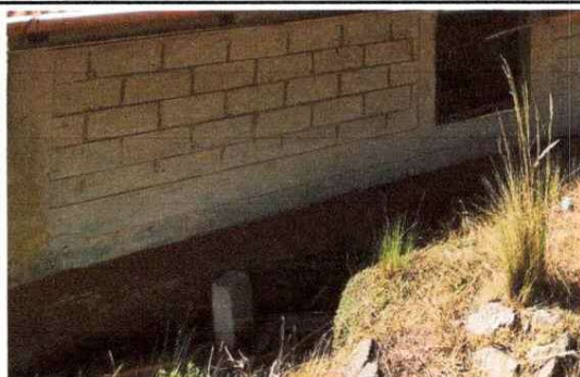
Foto 6: Pintura en muros interiores y exteriores
