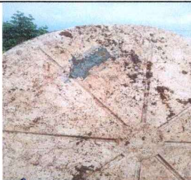
Foto 2: Reparación y mantenimiento de sisterna / depósito de agua.
