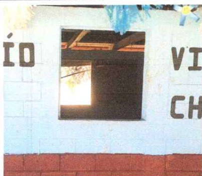
Foto 3: sustitución de ventana
