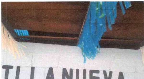
Foto 1: mejoramiento de muros
