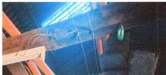
Foto 2: Madera deteriorada
