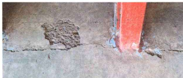
Foto 4: sustitución de piso
