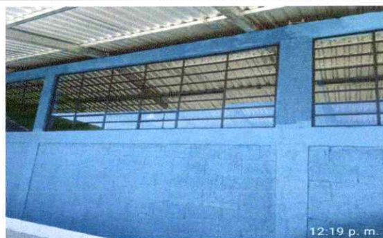
Foto 4: Sustitución de ventana de madera por metal más vidrio, sustituida.
