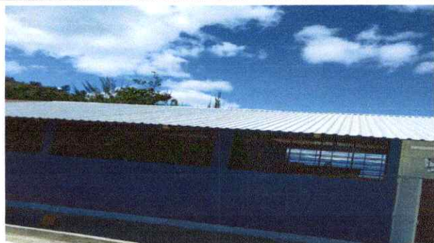
Foto 1: Sustitución de lámina por lámina troquelada finalizado.
