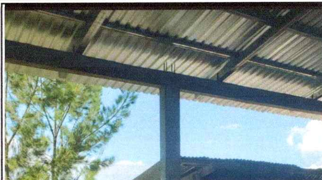
Foto 2: Sustitución de estructura de soporte de madera por metal concluida.
