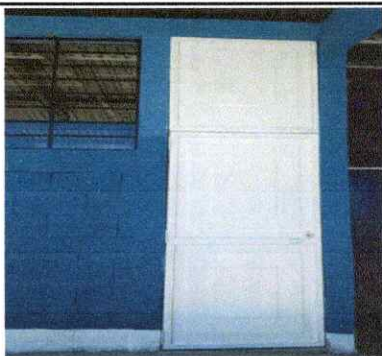
Foto 3: Sustitución de puerta de metal, sustituida.
