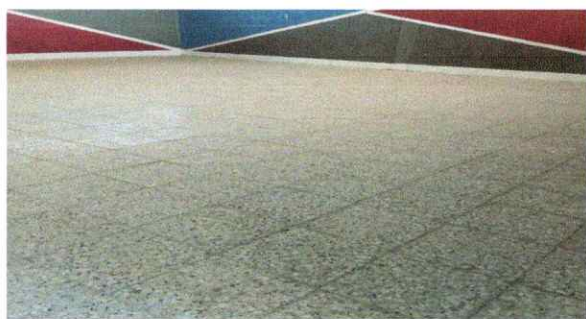
Foto 5: Sustitución de piso de torta de cemento por piso de granito, terminada
