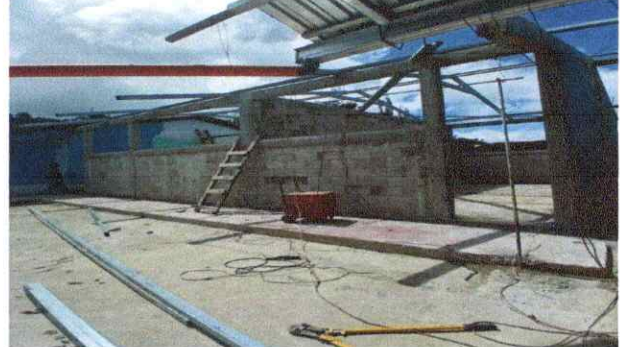
Foto 2: Sustitución de estructura de soporte de madera por metal en proceso.
