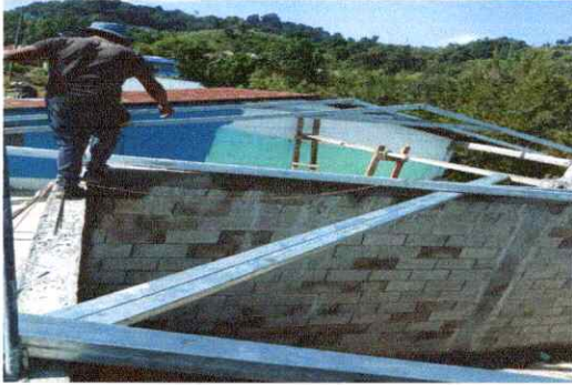
Foto 1: Sustitución de lámina por lámina troquelada en proceso.
