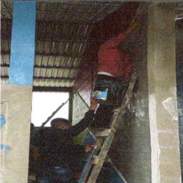
Foto 3: Sustitución de puerta de metal en proceso
