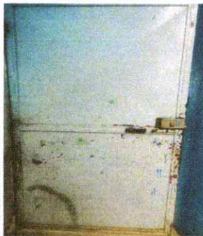
Foto 3: Sustitución de puerta de metal
