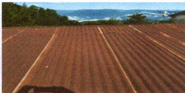
Foto1: Sustitución de lámina por lámina troquelada
