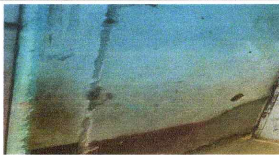
Foto 6: Pintura de muros exteriores e interiores
