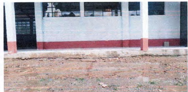
Foto 6: patio en mal estado genera humedad en el suelo del establecimiento
