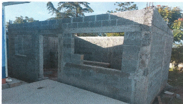
Foto 4: Mejoramiento de cocina en piso granito, estufa rural, mueble de concreto de cocina, pila, lavatrastes, deposito de agua, base de metal para depósito de agua.
