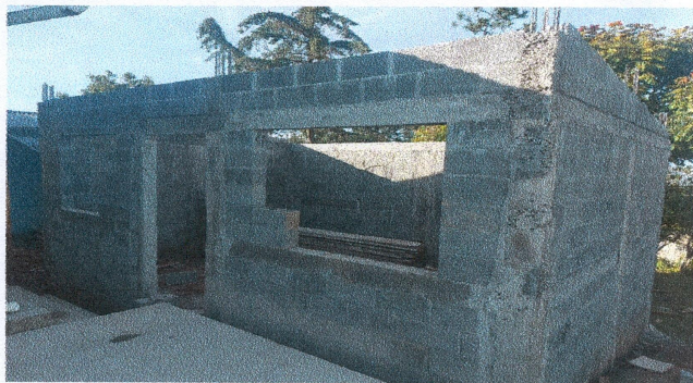
Foto1: Mejoramiento de cocina en cubierta y estructura de techo.
