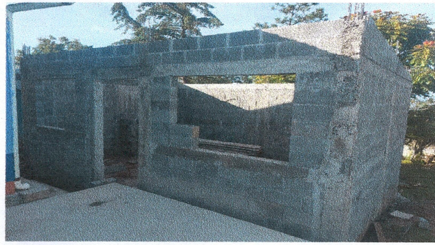
Foto 2: Mejoramiento de cocina en puerta y ventanas.
