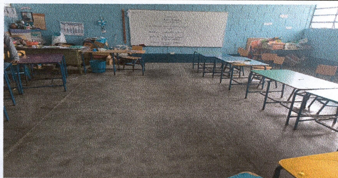
Foto 5: Sustitución de piso granito en modulo de aulas.
