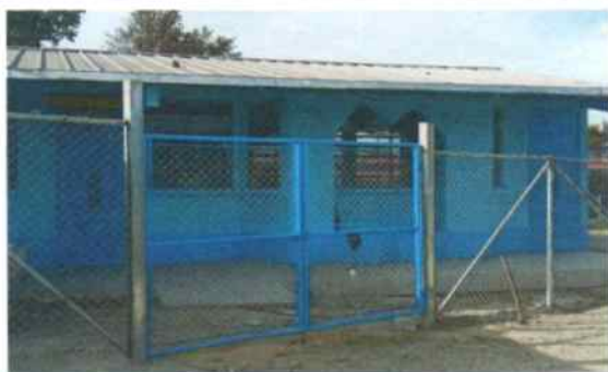
Foto 3: Canal de lámina galvanizada instalado
