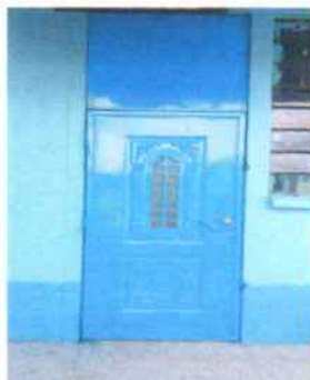
Foto1: Puertas de metal instaladas
