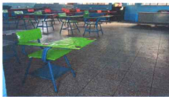
Foto 2: Piso de granito instalado
