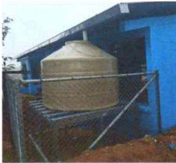
Foto 9: Depósito de agua instalado
