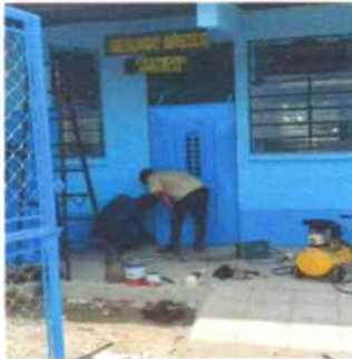
Foto1: Instalando puertas de metal
