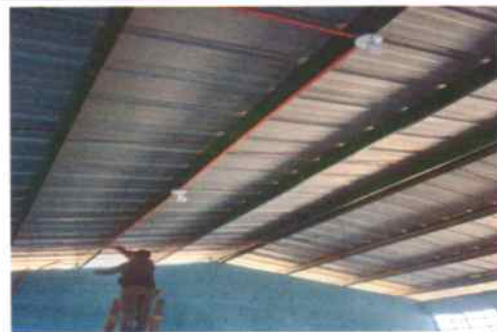
Foto 6: Instalación del sistema eléctrico
