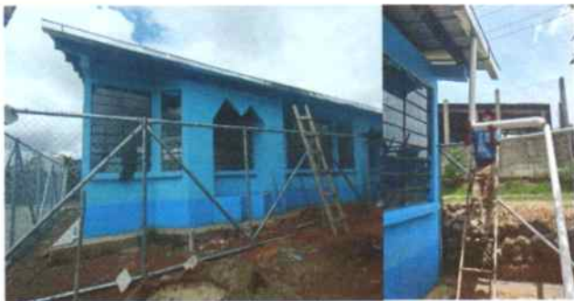
Foto 3: Instalando canal de lámina galvanizada y bajada de agua
