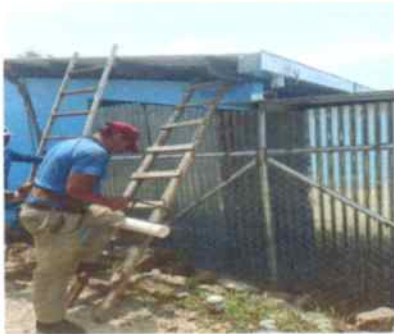
Foto 9: Instalando depósito de agua
