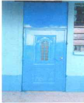
Foto1: Puertas de metal instaladas
