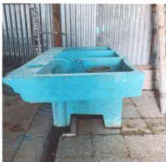
Foto 7: Pila de cemento instalada
