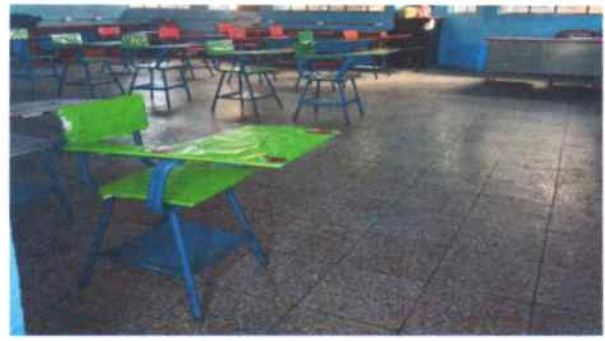
Foto 2: Piso de granito instalado
