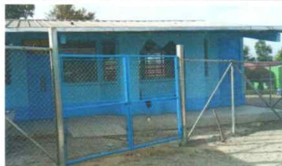
Foto 8: Portón de tubo HG y malla galvanizada instalado
