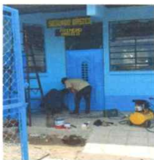
Foto1: Instalando puertas de metal
