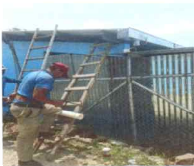
Foto 9: Instalando depósito de agua
