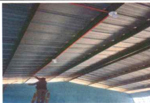
Foto 6: Instalación del sistema eléctrico
