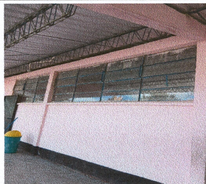
Foto 4: Aplicación de pintura en muros interiores y exteriores.
