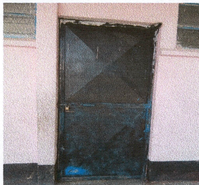
Foto 1: Mantenimiento a puertas de metal.
