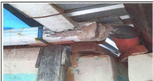
Foto 5: Canales deteriorados
