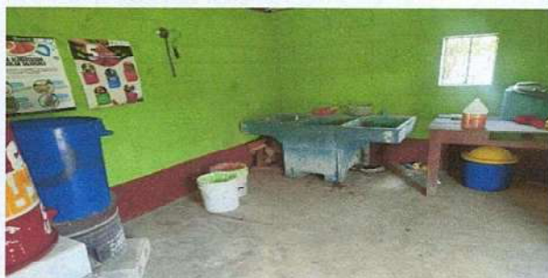
Foto 5: Mejoramiento del mueble de concreto para la cocina y pila ya no es funcional
