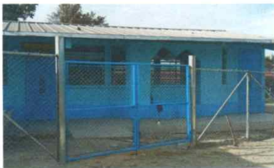
Foto 3: Canal de lámina galvanizada instalado
