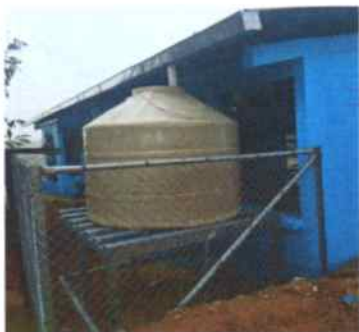
Foto 9: Depósito de agua instalado
