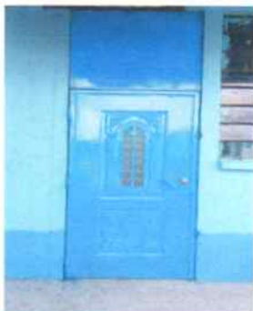
Foto 1: Puertas de metal instaladas
