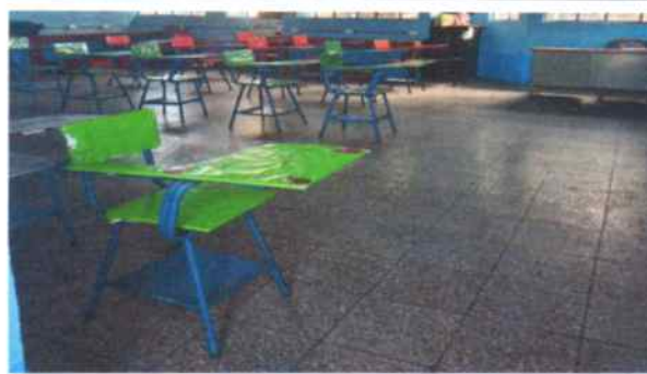
Foto 2: Piso de granito instalado
