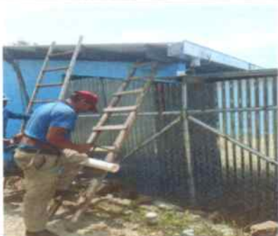
Foto 9: Instalando depósito de agua
