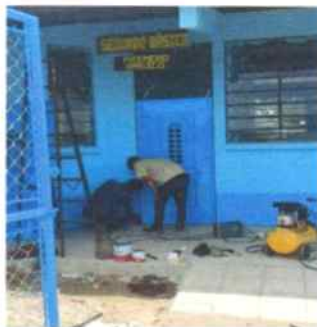
Foto1: Instalando puertas de metal
