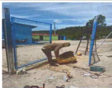
Foto 8: Instalando portón de tubo HG y malla galvanizada
