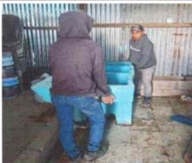
Foto 7: Instalando pila de cemento
