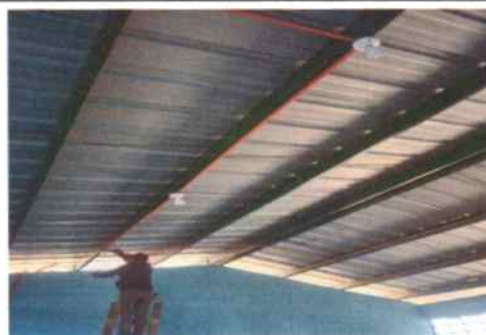
Foto 6: Instalación del sistema eléctrico
