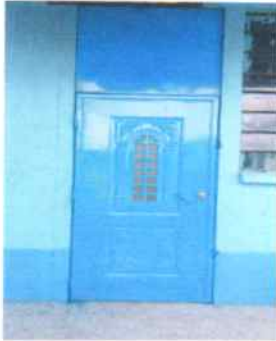
Foto 1: Puertas de metal instaladas
