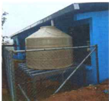
Foto 9: Depósito de agua instalado
