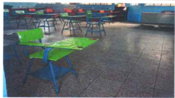
Foto 2: Piso de granito instalado
