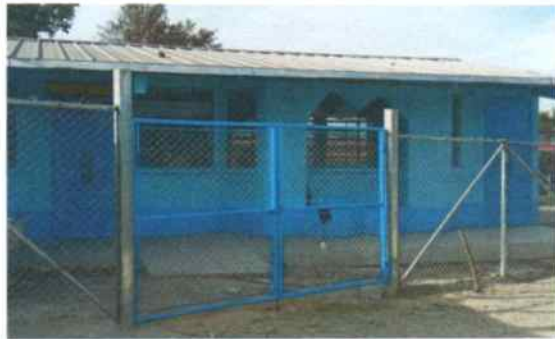
Foto 3: Canal de lámina galvanizada instalado
