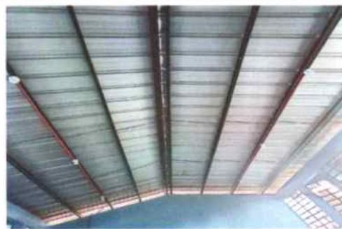
Foto 6: Sistema eléctrico instalado
