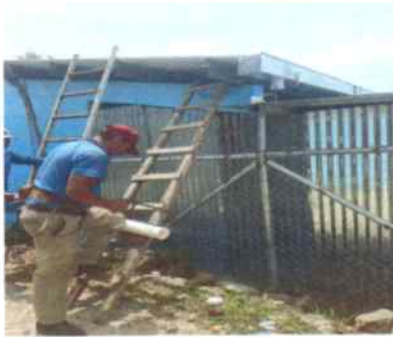
Foto 9: Instalando depósito de agua
