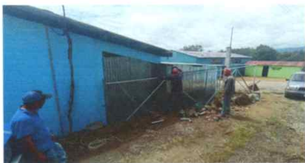
Foto 5: Instalando muro perimetral de tubo HG y malla galvanizada
