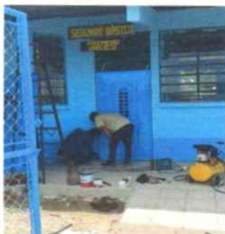
Foto1: Instalando puertas de metal
