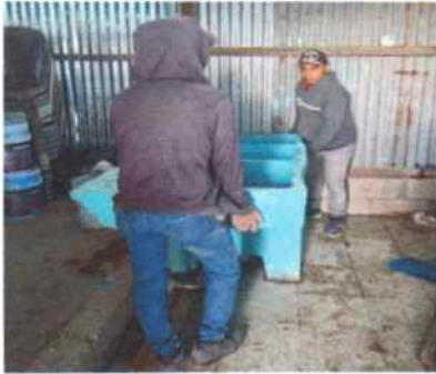
Foto 7: Instalando pila de cemento
