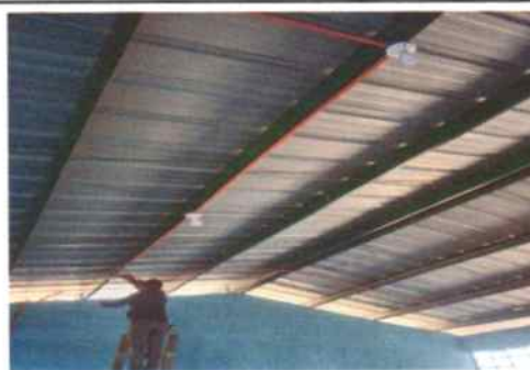
Foto 6: Instalación del sistema eléctrico
