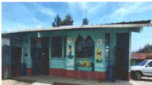
Foto 3: Canal de PVC en mal estado
