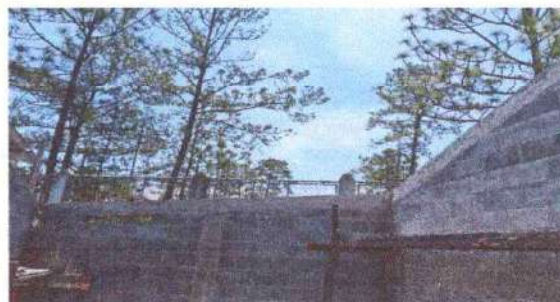
Foto 2: Mejoramiento de estructura de techo
