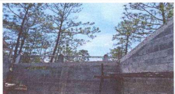
Foto 3: Mejoramiento de estructura de soporte de metal por metal galvanizado
