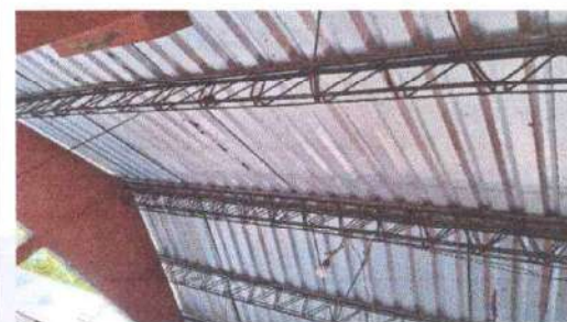
Foto 4: Sustitución de cubierta de lámina.
