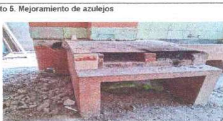
Foto 5: Mejoramiento de azulejos
