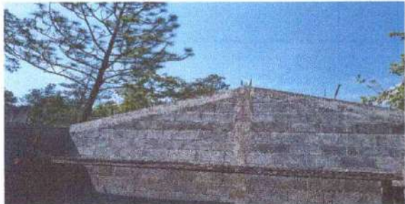
Foto 1: Mejoramiento de cubierta de la lámina
