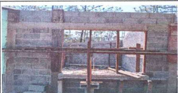
Foto 5: Mejoramiento de ventana y balcón de metal
