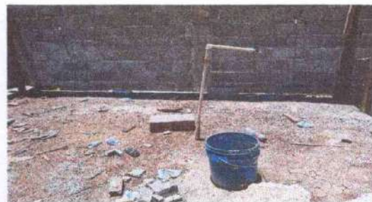
Foto 2: Mejoramiento de estufa rural
