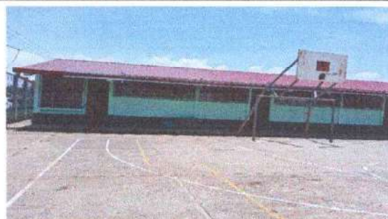
Foto 2: Aplicación de Pintura en las aulas de la escuela.
