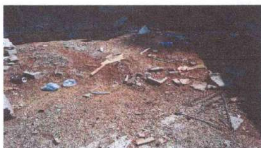
Foto 1: Mejoramiento de piso de granito.
