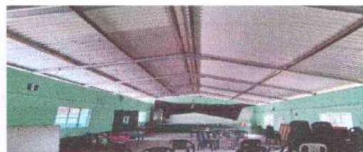
Foto 6: Mejoramiento de ducto eléctrico
