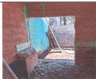
Foto 6: Mejoramiento de puerta de metal
