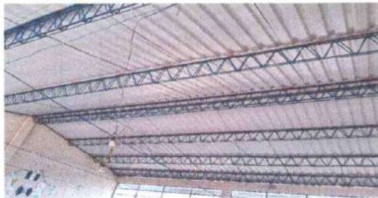
Foto1:Sustitución del sistema electrico en las aulas
