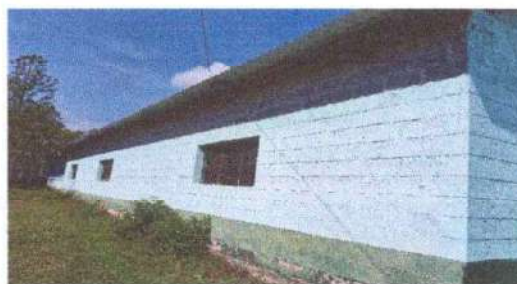
Foto 4: Aplicación de pintura en el salón escolar
