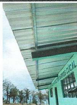
Foto 5: Techo no cuenta con canales y se está dañando pared e ingresa agua a las aulas
