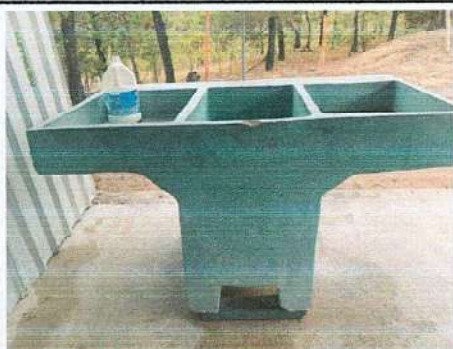
Foto 11: Pila en mal estado
