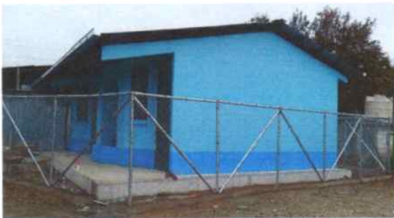
Foto 5: Muro perimetral de tubo HG y malla galvanizada instalado
