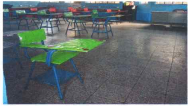
Foto 2: Piso de granito instalado
