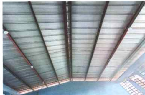
Foto 6: Sistema eléctrico instalado
