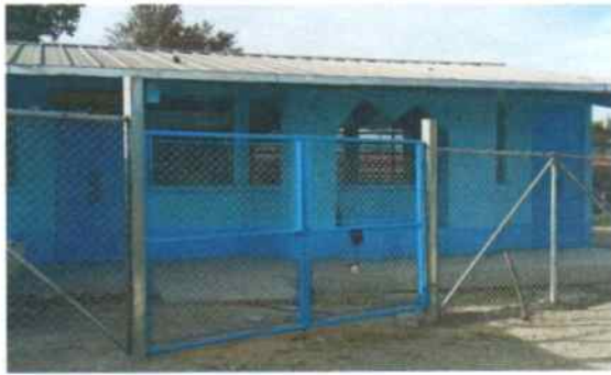
Foto 3: Canal de lámina galvanizada instalado
