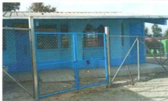
Foto 8: Portón de tubo HG y malla galvanizada instalado
