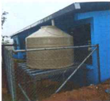
Foto 9: Depósito de agua instalado
