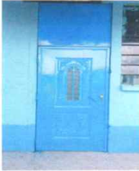
Foto 1: Puertas de metal instaladas
