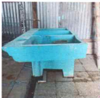
Foto 7: Pila de cemento instalada
