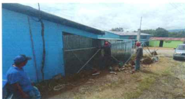
Foto 5: Instalando muro perimetral de tubo HG y malla galvanizada
