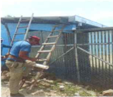
Foto 9: Instalando depósito de agua
