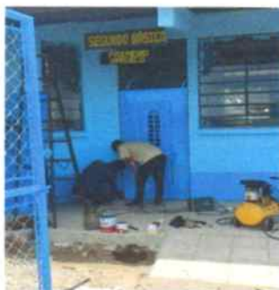
Foto1: Instalando puertas de metal
