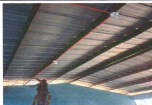
Foto 6: Instalación del sistema eléctrico
