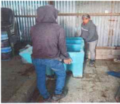
Foto 7: Instalando pila de cemento
