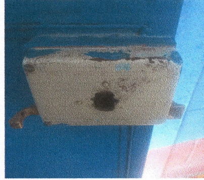
Foto 2: Sustitución de chapa y aplicación de pintura a puertral de metal.
