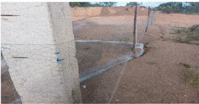
Foto 5: Mejoramiento de muro perimetral de tubo HG y malla galvanizada.
