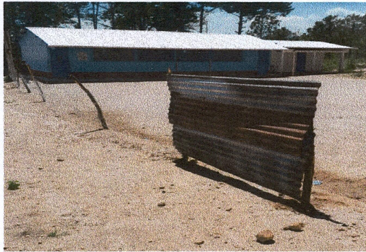
Foto 1: Sustitución de portón.
