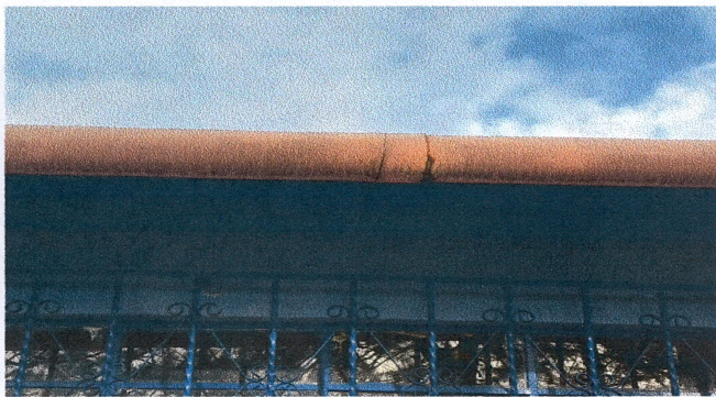
Foto 3: Sustitución de canal de PVC por canal de metal.
