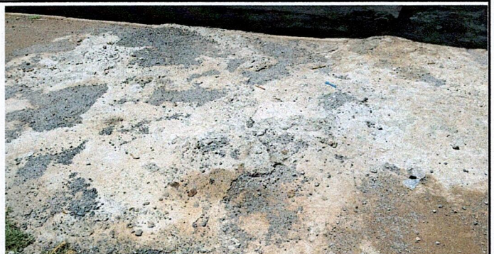
Foto 6: Sustitución de losa de patio
