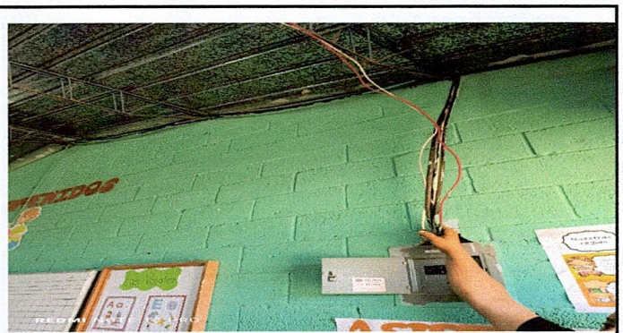
Foto 4: Reparación de sistema electrico
