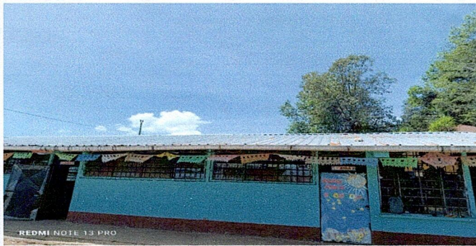
Foto1: Sustitucion cubierta de lamina
