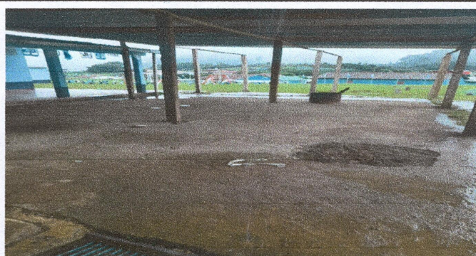
SUSTITUCIÓN DE ESTRUCTURA DE TECHO
