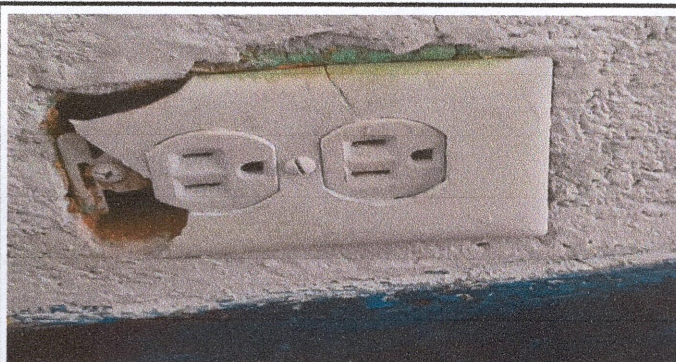
SUSTITUCIÓN DE SISTEMA ELECTRICO
