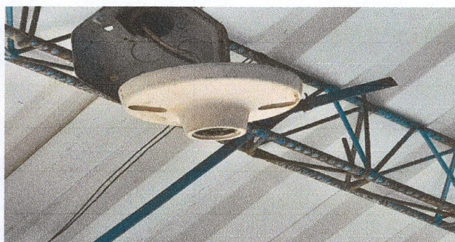
SUSTITUCIÓN DE SISTEMA ELECTRICO
