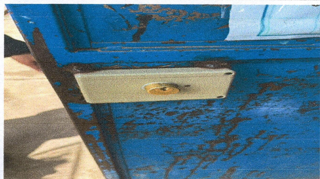
SUSTITUCIÓN DE CHAPAS
