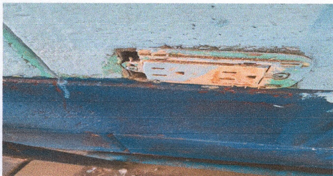
SUSTITUCIÓN DE SISTEMA ELECTRICO
