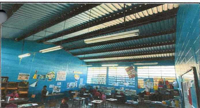
SUSTITUCIÓN DE FOCOS AHORRADORES
