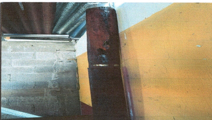
SUSTITUCIÓN DE CHIMENEA DE CONCRETO
