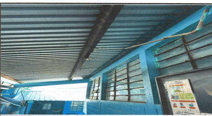
SUSTITUCIÓN DE DUCTO ELÉCTRICO Y SUS ACCESORIOS
