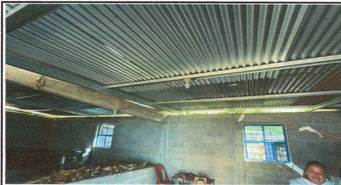
SUSTITUCIÓN DE LAMINA
