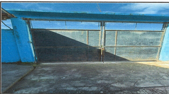
MANTENIMIENTO A PORTÓN DE METAL
