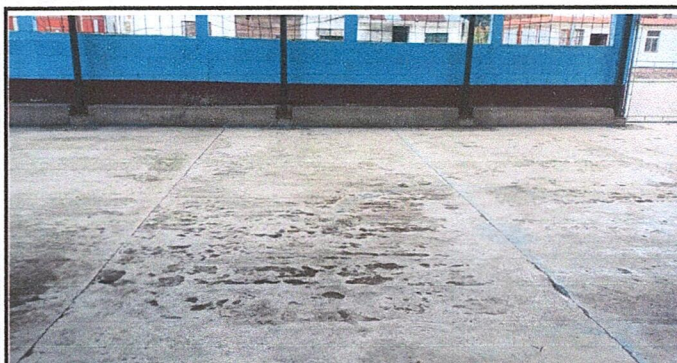
Foto 6: Sustitución de piso de torta de concreto
