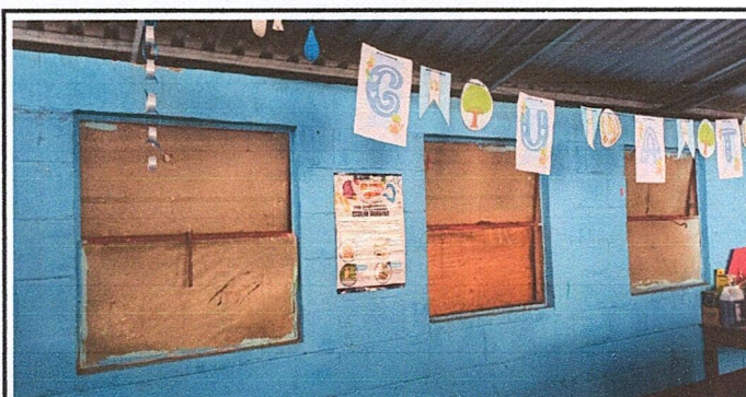
Foto 5: Sustitución de estructura de metal de ventana
