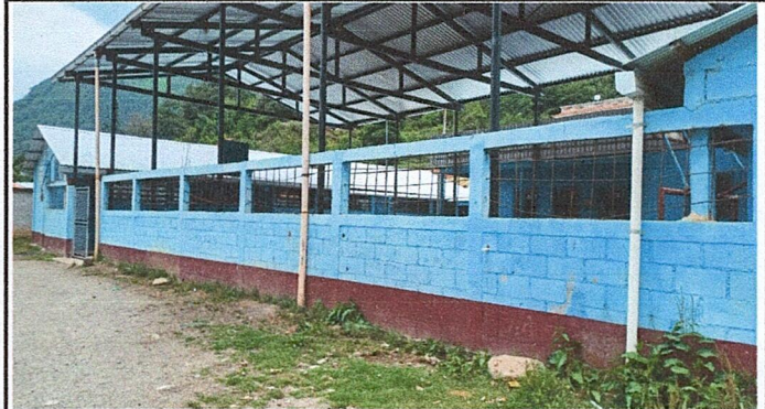
Foto 8: Pintura en muros exteriores e interiores
