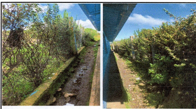
Foto 4: Reparación de tubo hg y malla galvanizada
