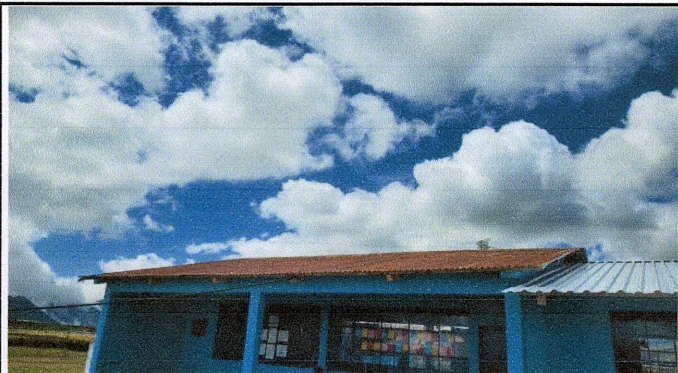
Foto1: Sustirución de lámina, por lámina troquelada aluzinc calibre 26
