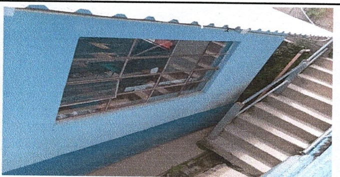
Foto 5: Mejoramiento de canal de agua pluvial
