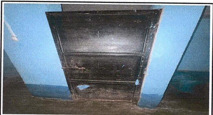
Foto 4: Sustitución de puertas (2 mts.de alto por 1 mts. De ancho.)
