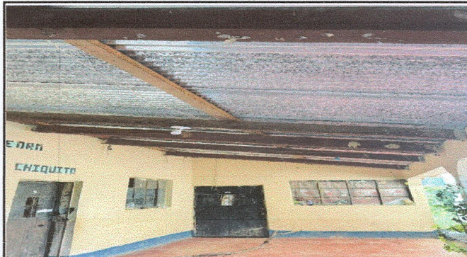
Foto2: Sustitución de estructura de madera por metal
