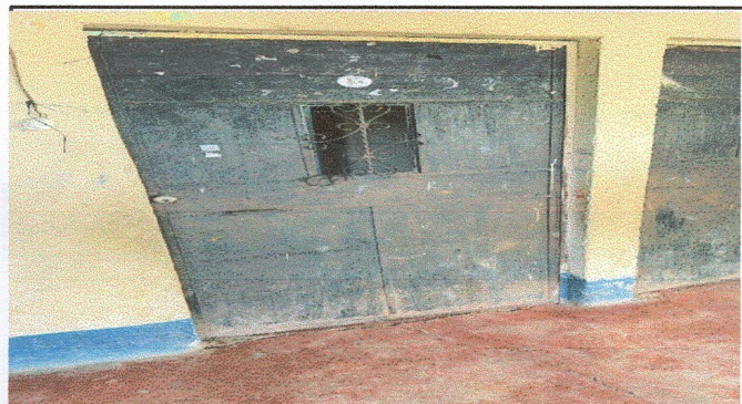
Foto 3: Sustitución de puerta de metal
