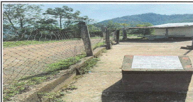
Foto 5: Mejoramiento de malla galvanizada y tubo HG
