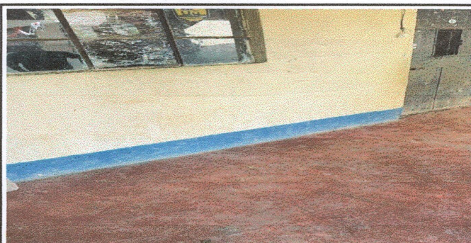
Foto 6: Pintura en muros interiores y exteriores
