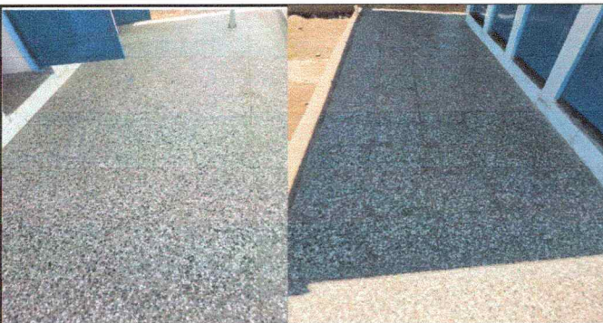
Foto 5: Sustrucción de piso de torta de concreto
