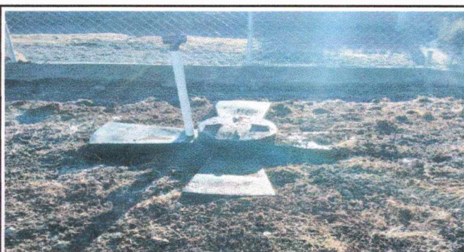
Foto 12: Mejoramiento de biodigestor 3,000 litros
