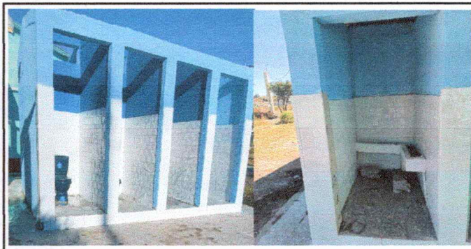
Foto 6: Instalación de azulejo en baños
