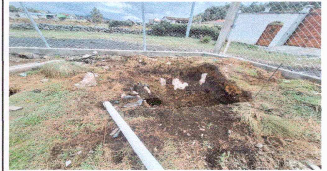
Foto 12: Mejoramiento de biodigestor 3,000 litros
