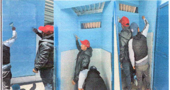
Foto 8: Pintura en muros exteriores e interiores
