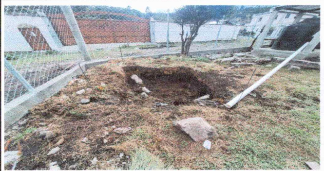
Foto 11: Mejoramiento de biodigestor 3,000 litros
