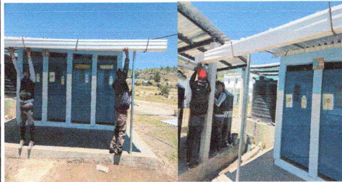
Foto7: Mejoramiento de canal de pvc y bajada de agua pluvial, tubo PVC 3"
