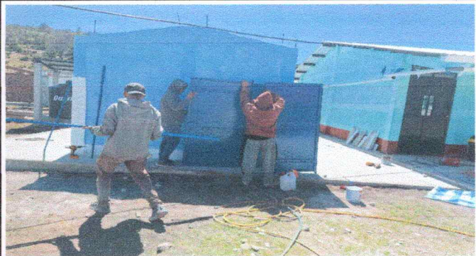
Foto 4: Sustitución de puerta de metal de 0.81 centímetros de ancho por 1.80 metros de alto
