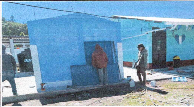
Foto 3: Mantenimiento a estructura (lijado, ampliación, aplicación de pintura y colocación de chapa) de 0.81 centímetros de ancho por 1.80 metros de alto
