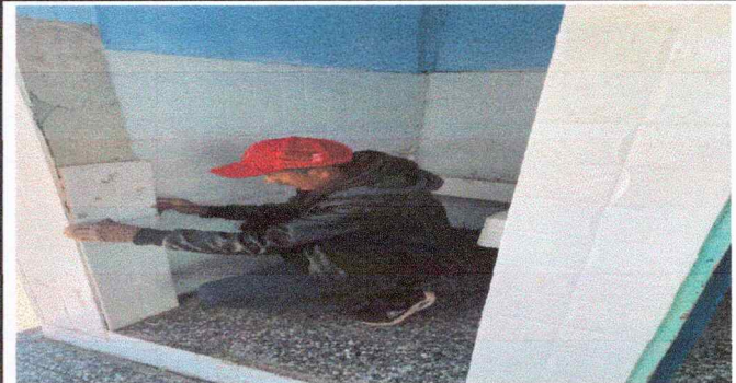
Foto 6: Instalación de azulejo en baños
