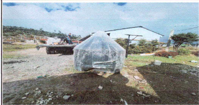
Foto 10: Mejoramiento de biodigestor 3,000 litros
