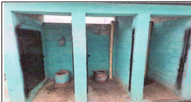
Foto 9: Sustitución de baños ciegos por servicios sanitarios lavables
