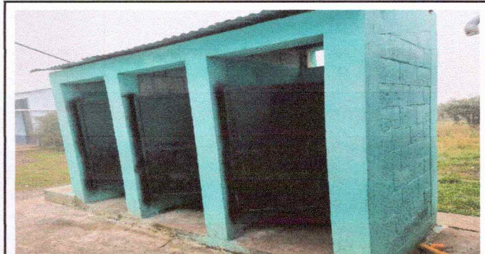
Foto 4: Sustrucción de puerta de metal de 0.81 centímetros de ancho por 1.80 metros de alto
