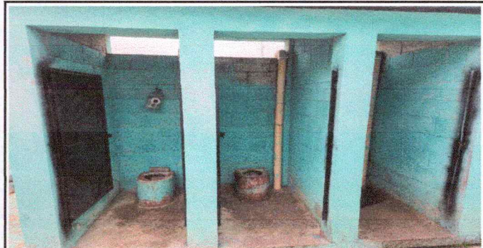
Foto 6: Instalación de azulejo en baños
