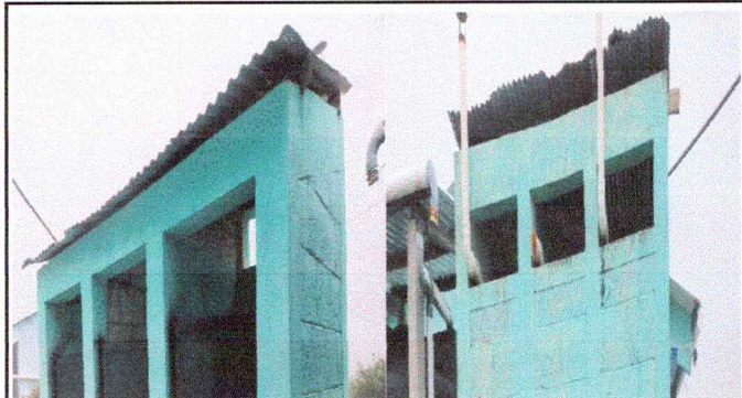
Foto 7: Mejoramiento de canal de pvc y bajada de agua pluvial, tubo PVC 3"
