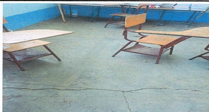
FOTO1: Sustitución de piso por piso granito
