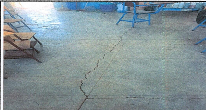
FOTO2: Sustitución de piso por piso granito
