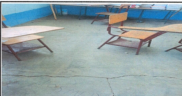
FOTO 5: Sustitucion de piso por piso granito
