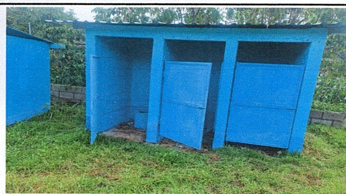
FOTO 3: Sustitución de puertas de metal en sanitarios
