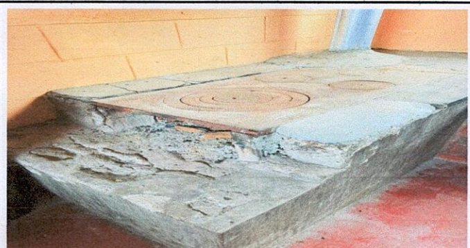
Foto 5: Sustitución de estufa rural (completa) chimenea y plancha
