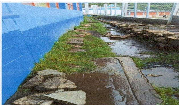
Foto 8: Reparación de banqueta de concreto
