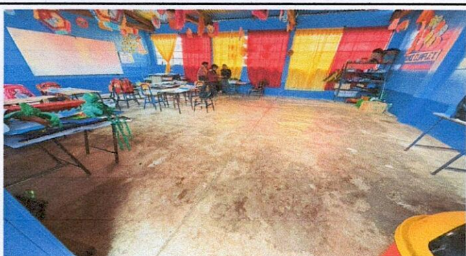
Foto 3: Sustitución de piso de granito
